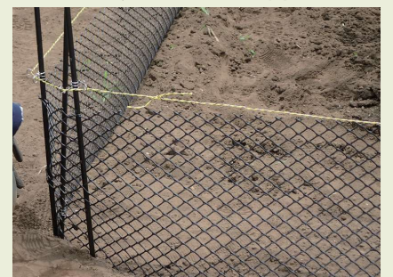
写真6 防護柵と電気柵を組み合わせた簡易複合柵
