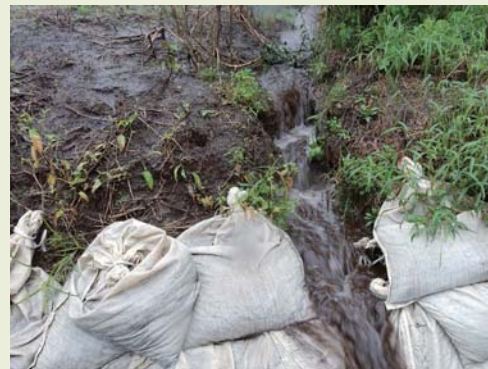
写真2 土のうの設置
